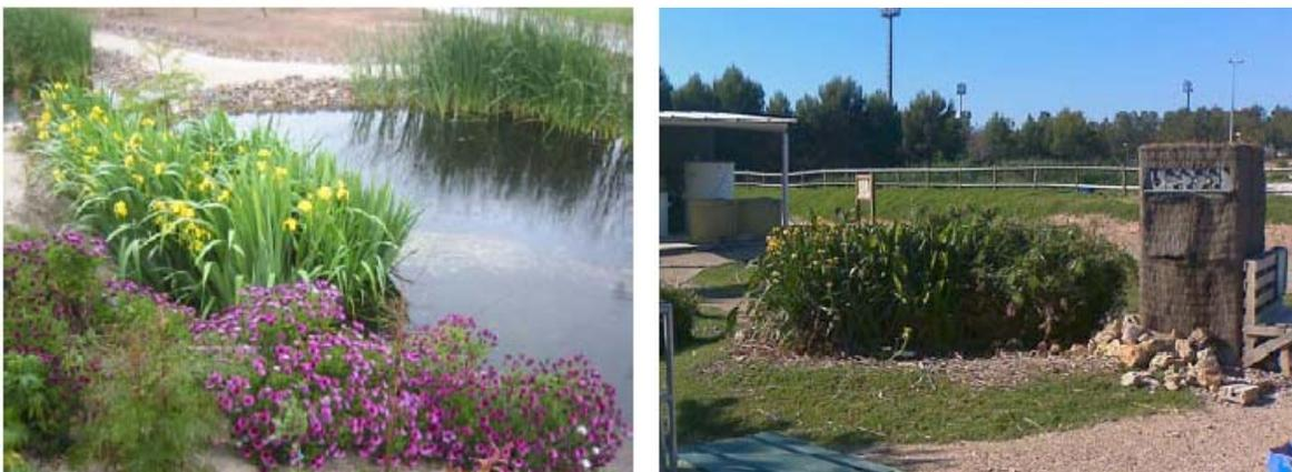
Foto 3. Aspecto del reactor y humedal en un sistema de tratamiento biológico ó depuradoras ecológicas
